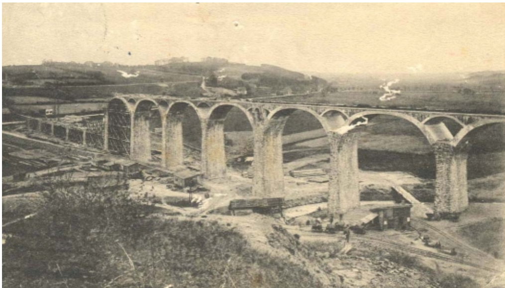
Brückenbauarbeiten an der Delecker Brücke / Verbindung der Provinzialstraße von Arnsberg nach Soest um 1910
