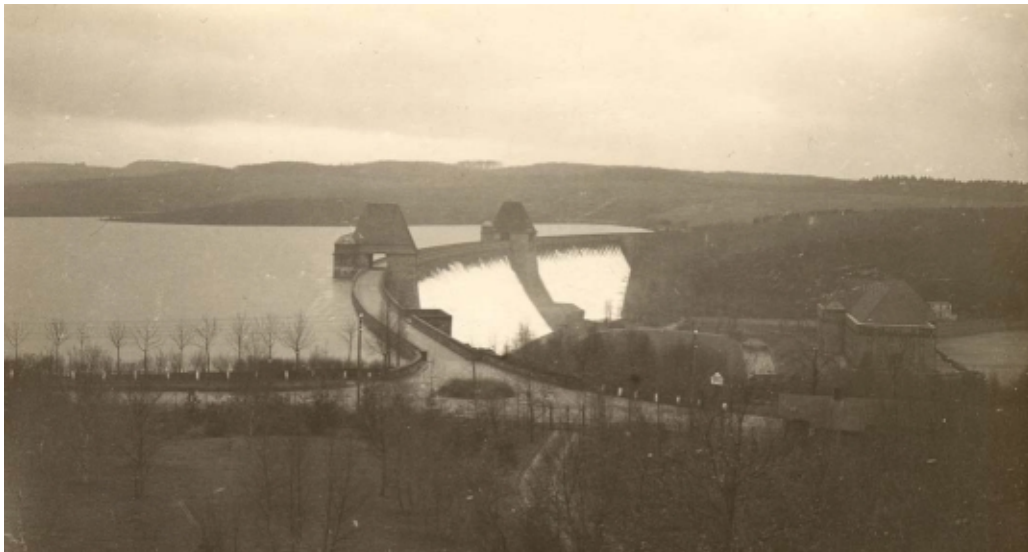
Blick auf die fertige Staumauer um 1915
